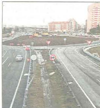
Nueva rotonda en la autopista «Y».
